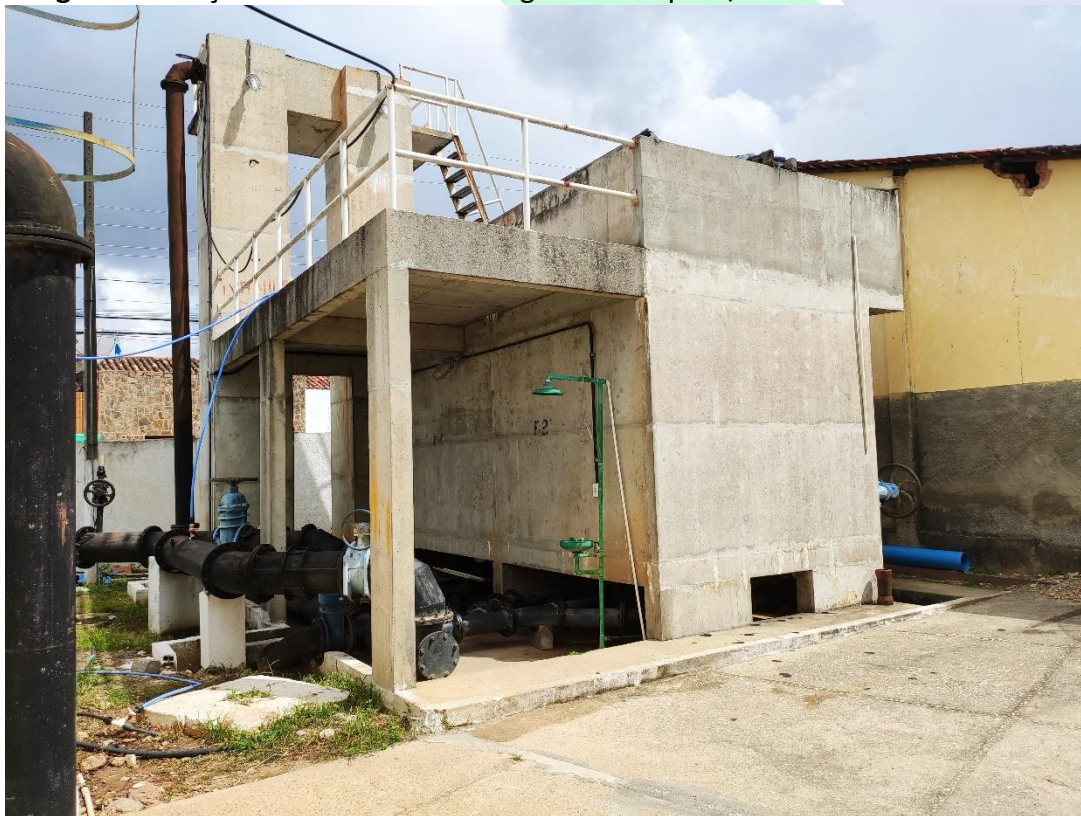
Imagem 1: Estação de Tratamento de Água de Neópolis/SE.
