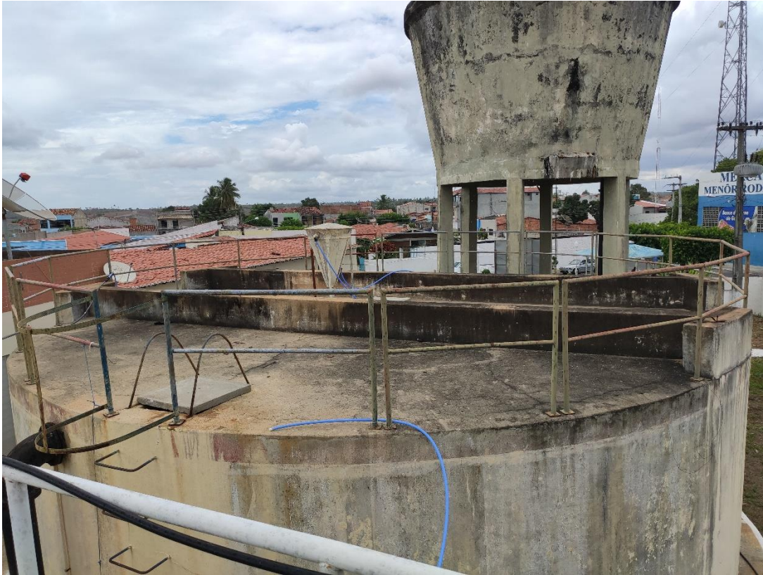
Imagem 2: Reservatórios Apoiado e Elevado da ETA.
