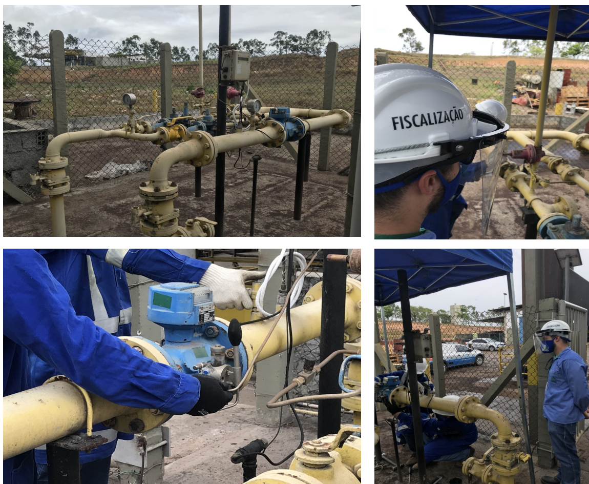
Figura 1: Substituição do medidor de vazão na ERPM TROPFRUIT
