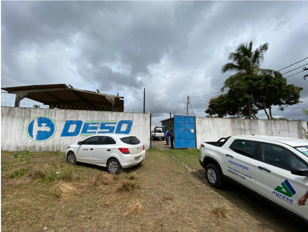
Imagem 1: Estação de Tratamento de Água – Siriri.
