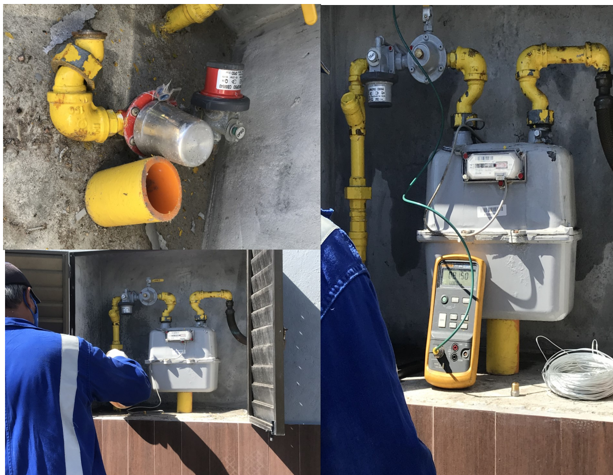
Figura 3: Substituição do medidor de vazão na ERPM TROPFRUIT
