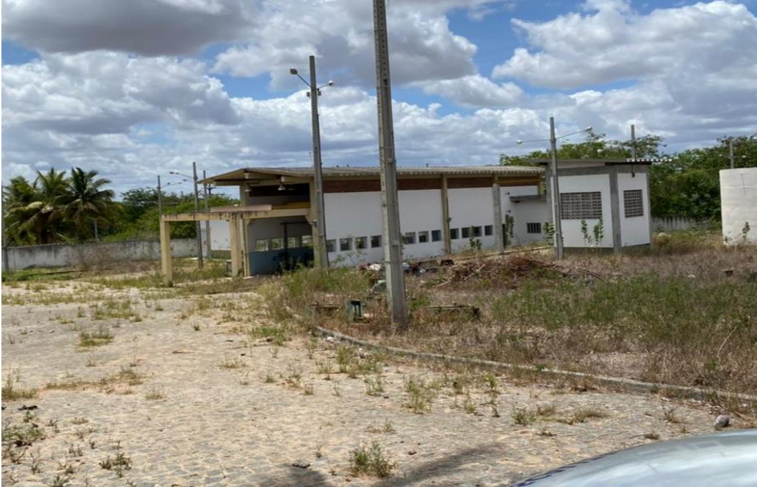
Imagem 3 – Estação Elevatória – EE2.
