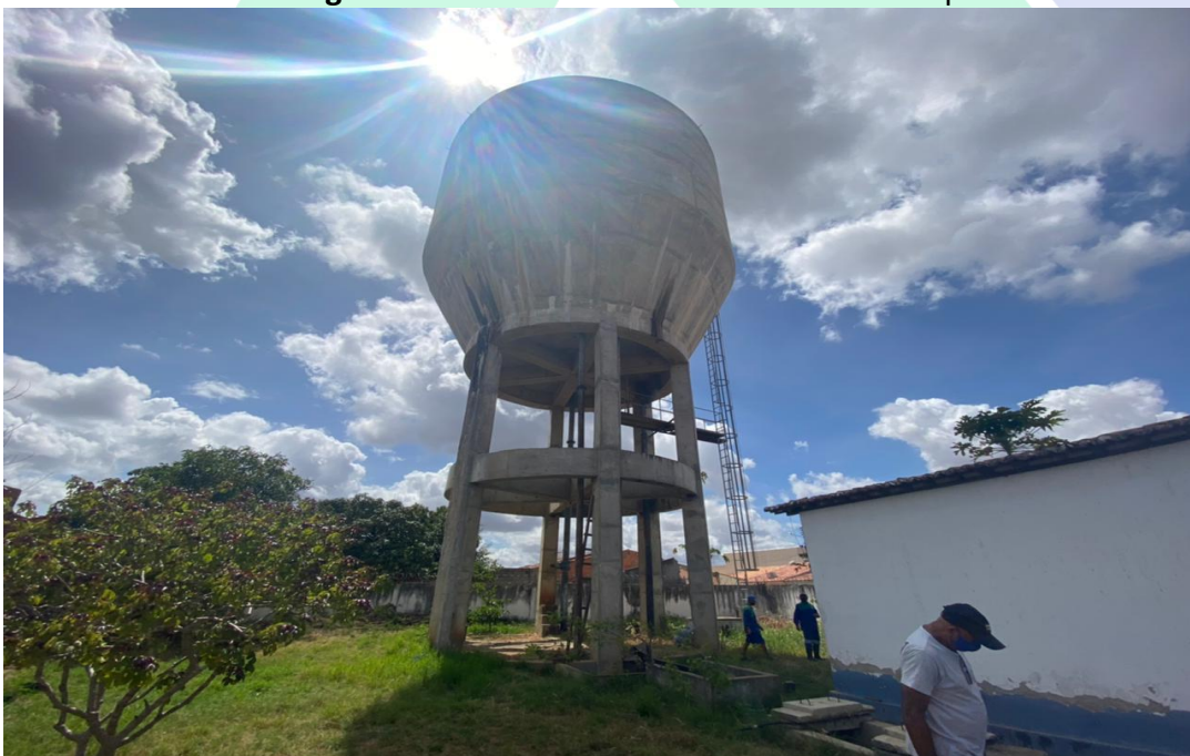
Imagem 2: Reservatório Elevado – sede municipal.
