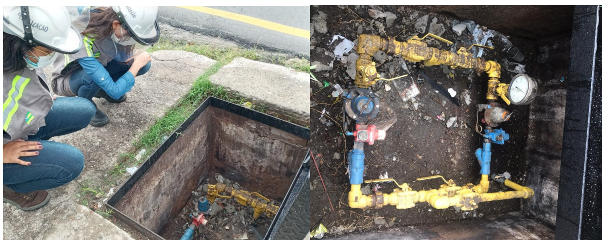
Figura 3 : Manutenção na ERP DES. MAYNARD II
