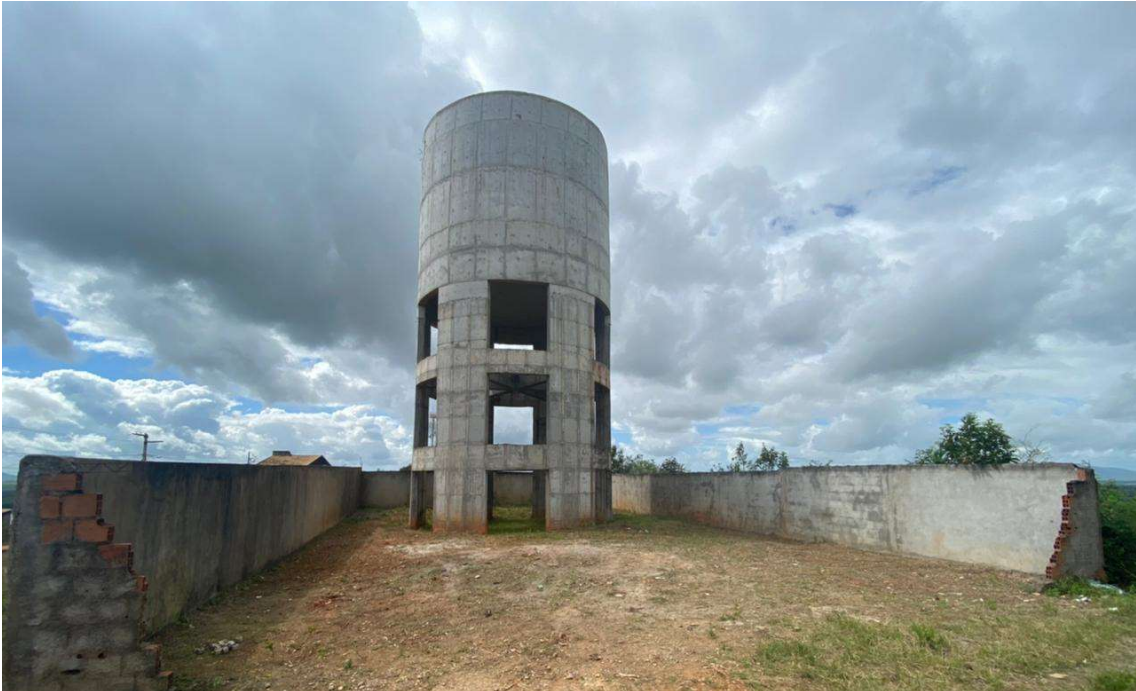
Imagem 1: Reservatório Elevado que irá compor o sistema de abastecimento de água do município.
