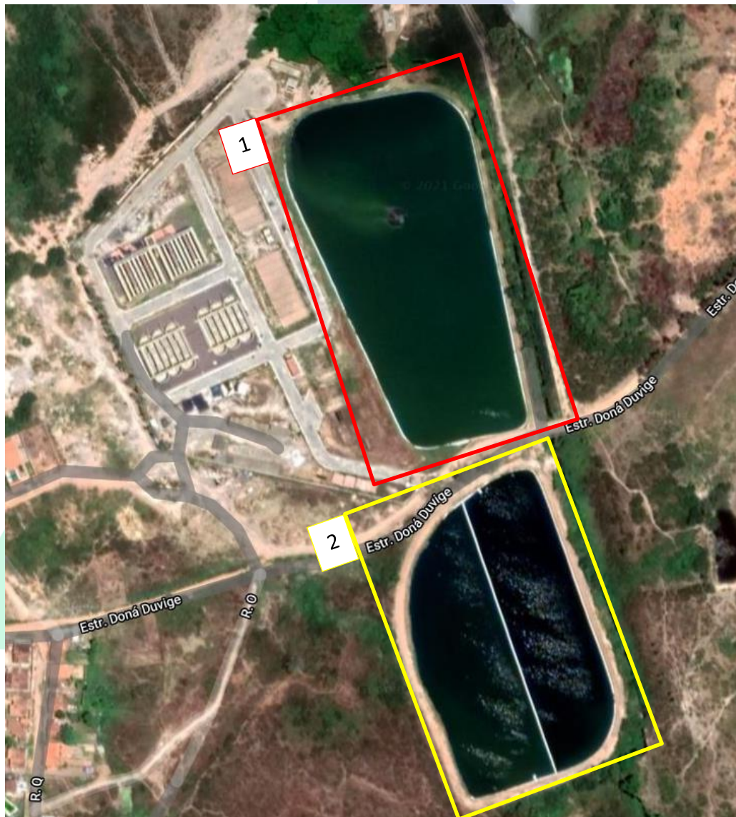
Imagem 1: Visão aérea da ETE Lagarto, (1) Lagoa Anaeróbia e (2) Lagoas Facultativas.
