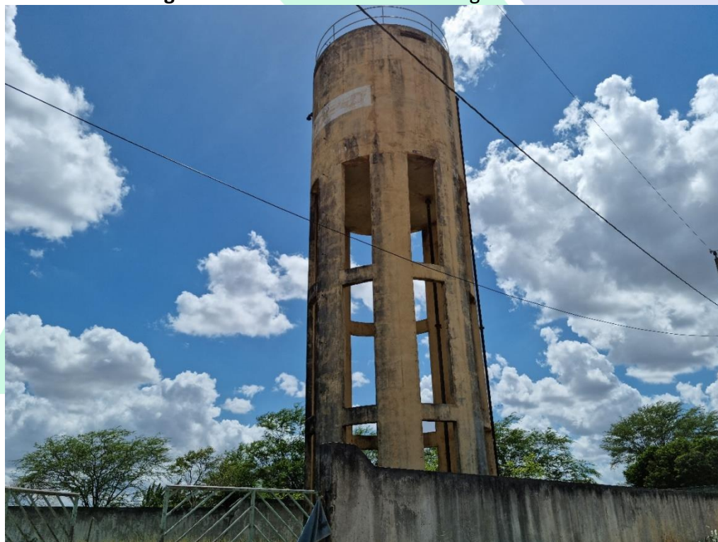
Imagem 4: Reservatório Elevado – Lagoa do Veado.
