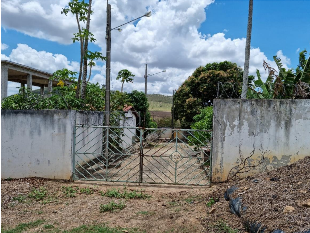
Imagem 1: Entrada da área da Estação Elevatória de Água Tratada, Reservatório Apoiado e Ponto de reforço de desinfecção (EE-3) – Cruz das Graças.
