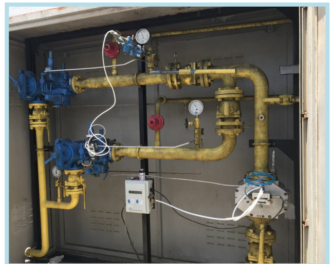
Figura 4: Exemplo de uma ERP encontrada em postos de combustíveis
