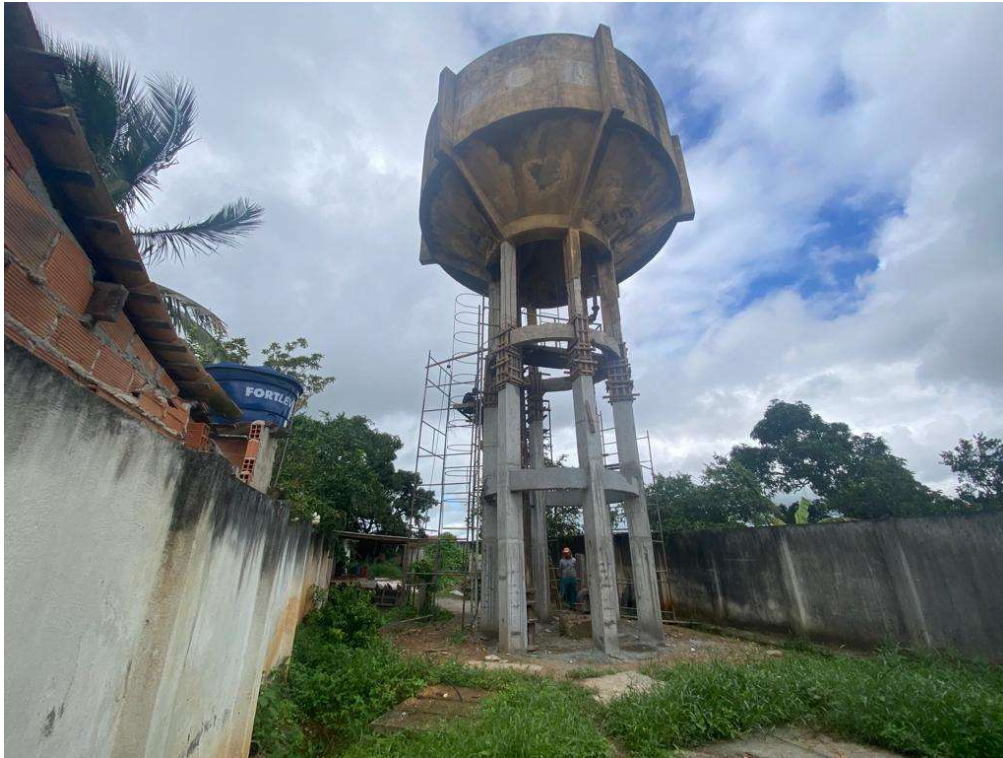
Imagem 1: Reservatório elevado – Área 1000 (sede municipal).
