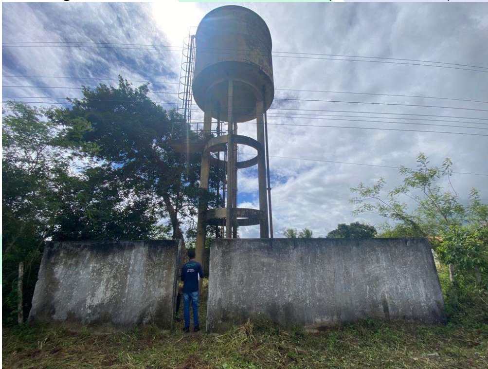
Imagem 2: Reservatório Elevado – Área 1300 (Pov. Pedra Branca).
