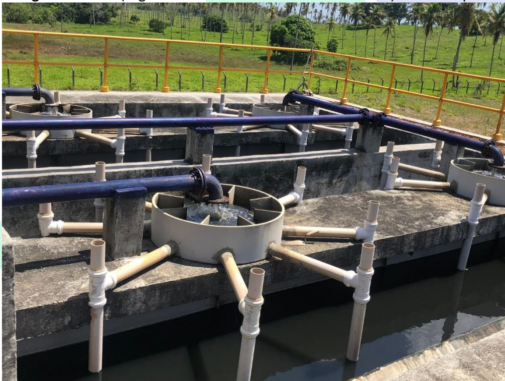
Imagem 4: DAFA (Digestor Anaeróbio de Fluxo Ascendente) – Vista Superior.
