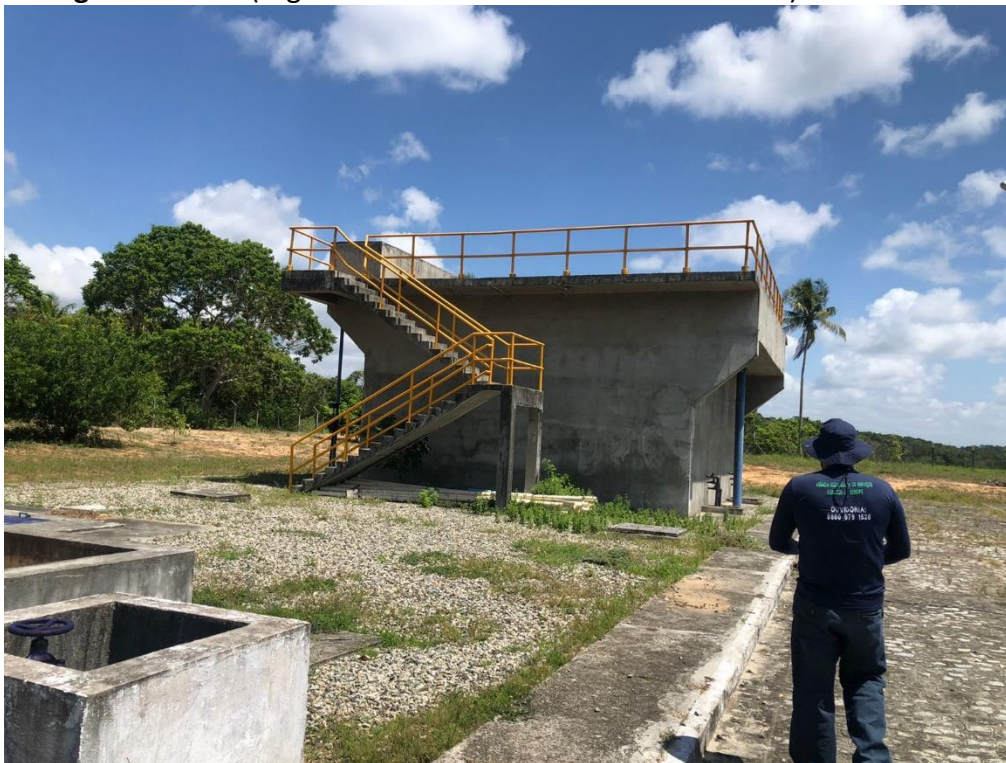
Imagem 3: DAFA (Digestor Anaeróbio de Fluxo Ascendente) – Vista Lateral.
