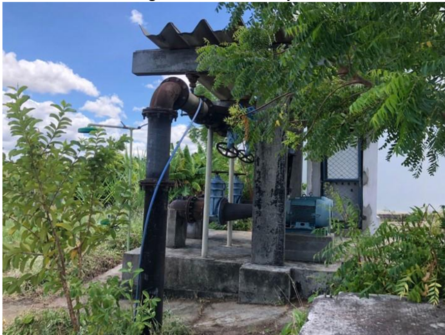
Imagem 2: EEAT – ETA Cajueiro.
