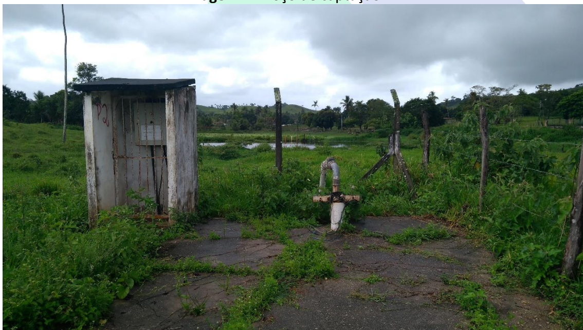
Imagem 2 - Poço de captação P2.
