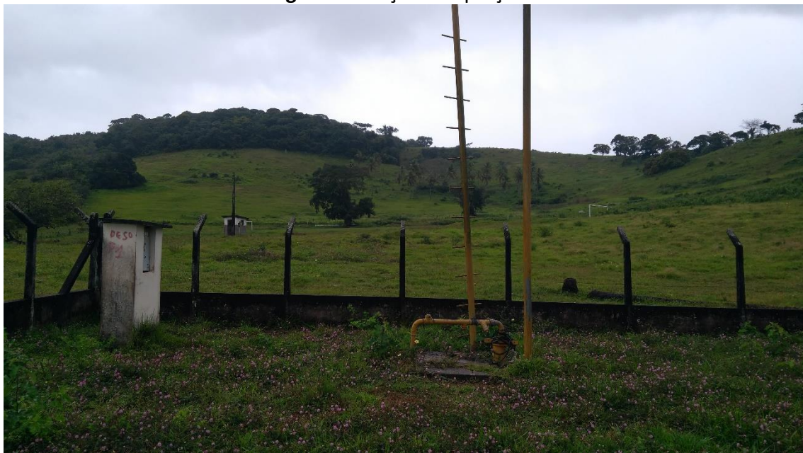
Imagem 1 – Poço de captação P1.
