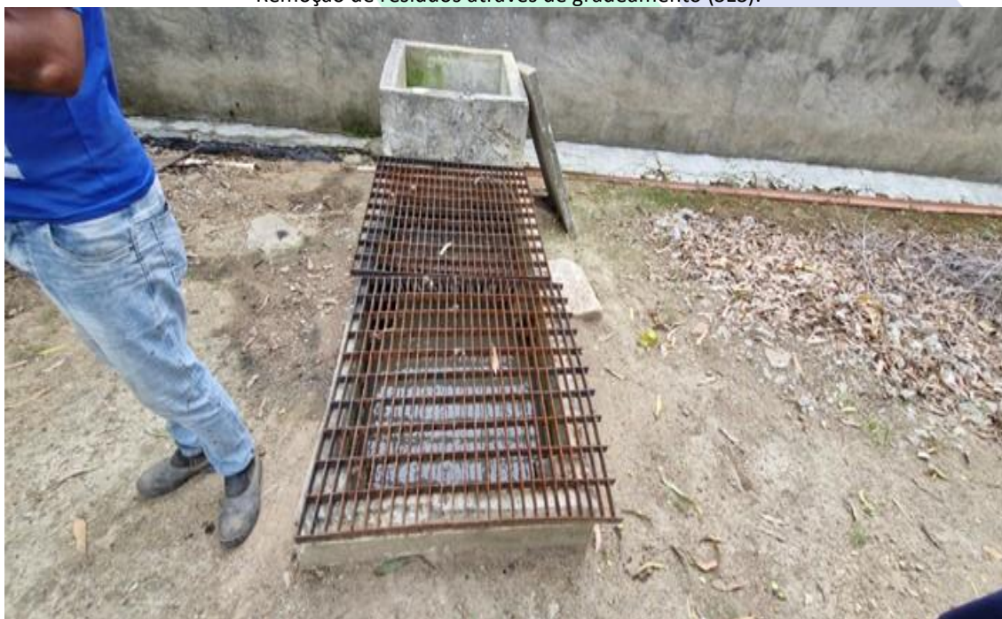
Imagem 3: Chegada do efluente na estação e Remoção de resíduos através de gradeamento (SES).
