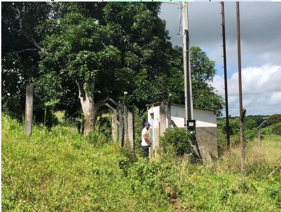
Imagem 2: Área do ponto de captação – povoado Poço dos Bois.
