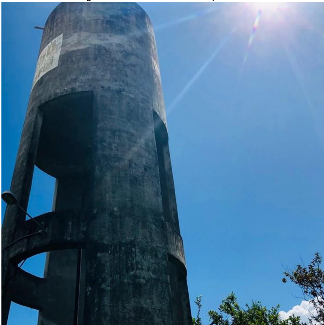
Imagem 3: Reservatório Elevado – Poço dos Bois.
