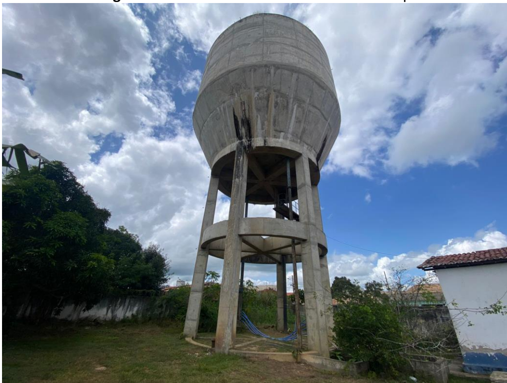
Imagem 1 – Reservatório Elevado – sede municipal.
