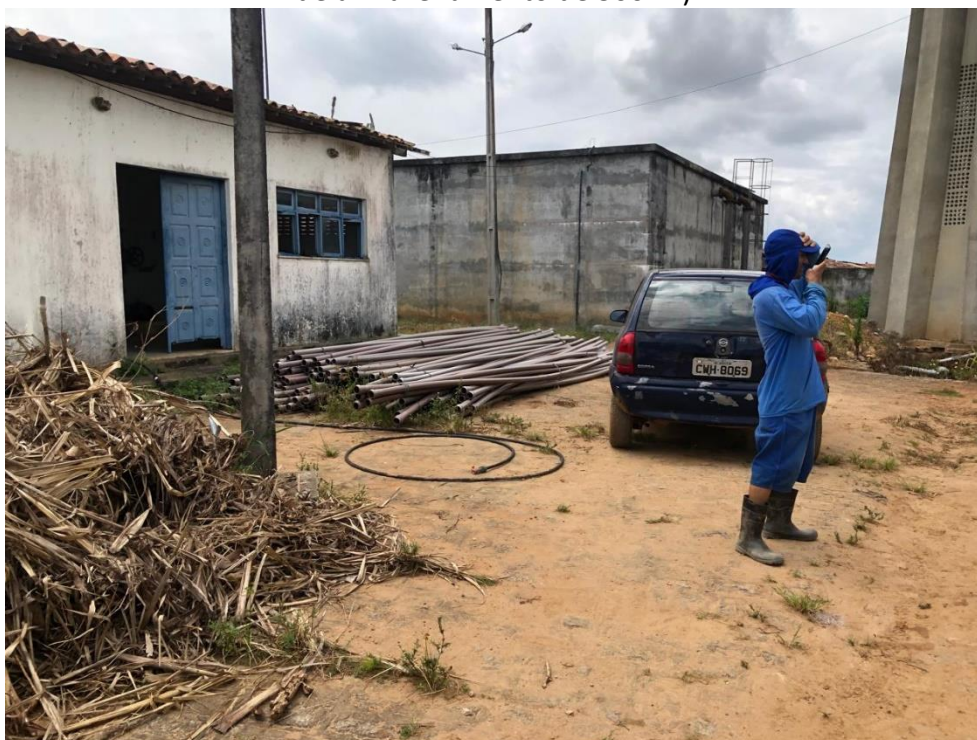
Imagem 1: Estação Elevatória R 7 (Sede) e Reservatório Apoiado – Sede (Capacidade de armazenamento de 500m 3 ).
