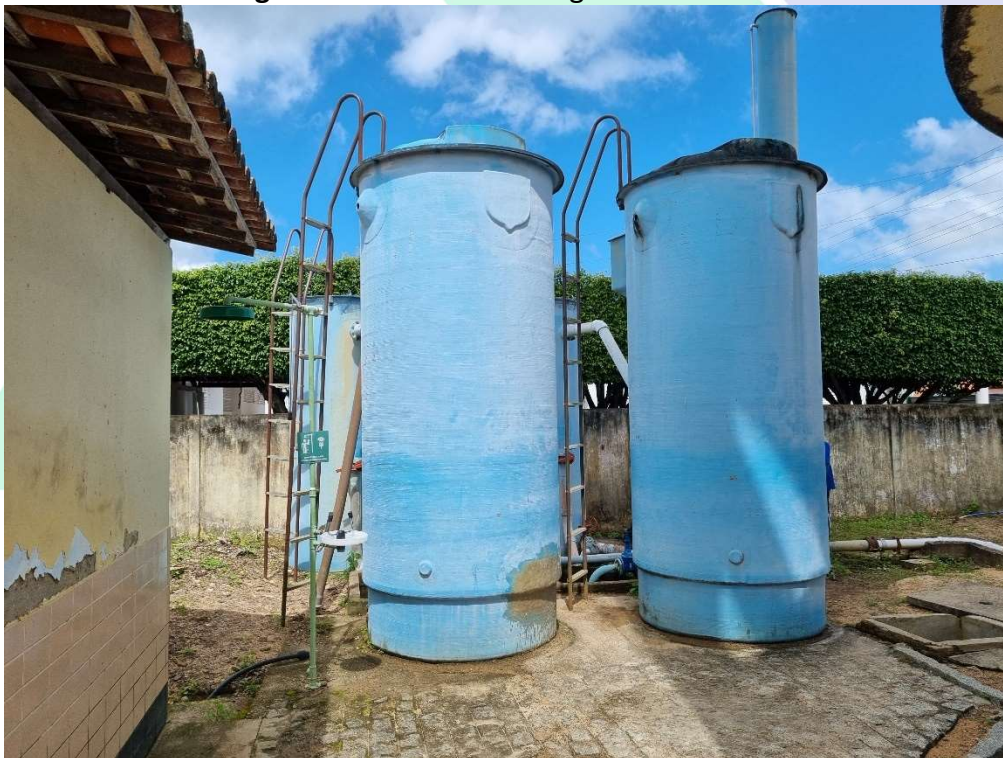
Imagem 10 – Câmara de carga e filtros da ETA.
