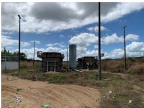
Vista geral da área da ETA
