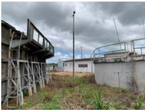
Reservatório de água de lavagem
