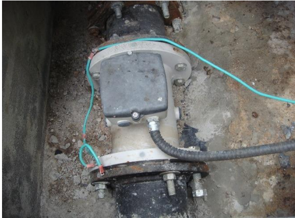
Vista de um dos medidores eletromagnéticos instalados nas saídas do T-1
