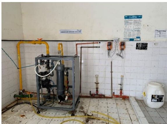
Sistema de geração de dióxido de cloro
