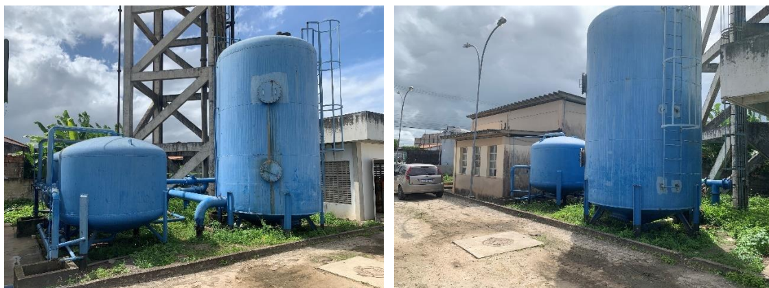
Vistas gerais do floculador e filtros pressurizados
