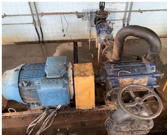
Detalhe de um conjunto elevatório
