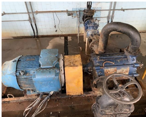
Detalhe de um conjunto elevatório
