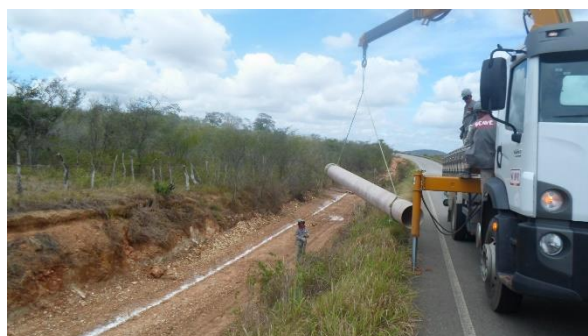
Adutora da CP para Ribeirópolis e Moita Bonita diâmetro 400 mm
