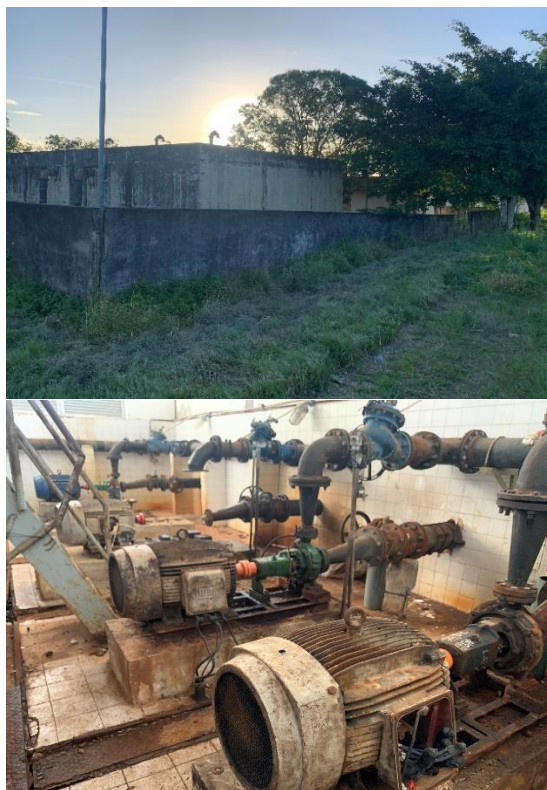
Vistas externas do reservatório apoiado de 500 m 3 e internas da Estação Elevatória
