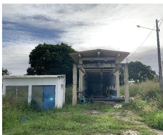
Vista externa da estação elevatória
