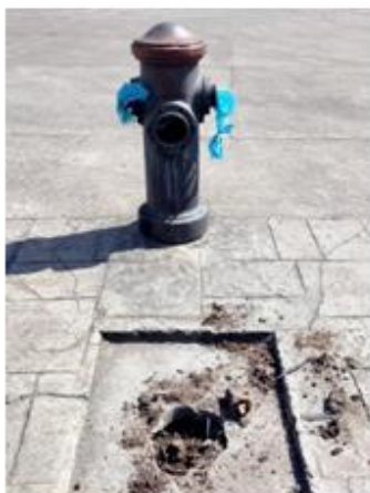
Figura 9 – Reparo de registro em hidrante de coluna
