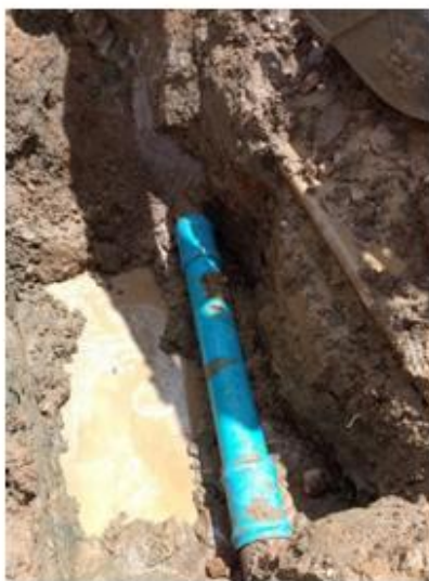
Figura 8 - Reparo de vazamento de rede DN 150mm
