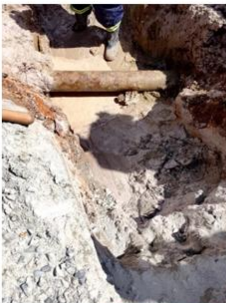
Foto 6 - Reparo de vazamento de rede CA 125mm
