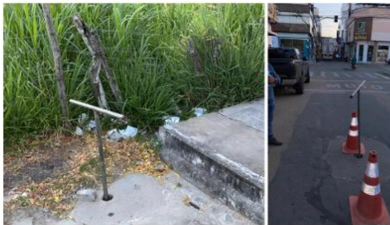
Foto 3 - Conferência das descargas da rede de distribuição de Itabaiana
