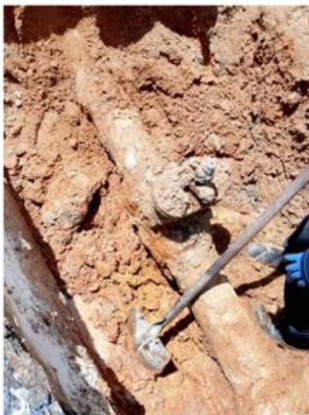
Foto 5 - Reparo de vazamento em registro DN 200
