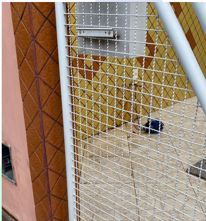
Figura 3: Residência utilizando motobomba para sucção da água na rede de distribuição.
