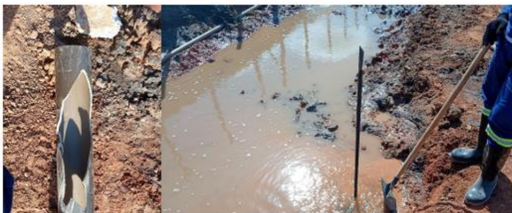
Figura 7 - Reparo de vazamento da adutora Cajaíba / Itabaiana
