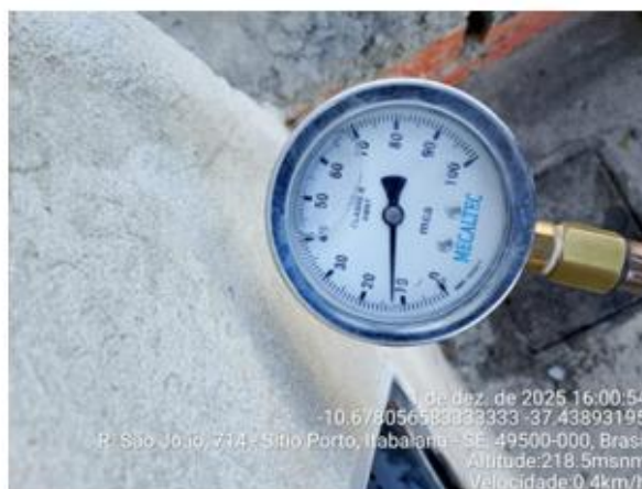
Foto 26 - Medição de pressão no bairro Sítio Porto
