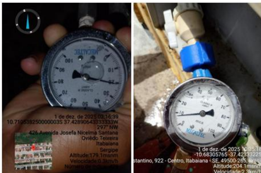
Foto 23 - Medição de pressão no Centro de Itabaiana e no Bairro Oviêdo Teixeira
