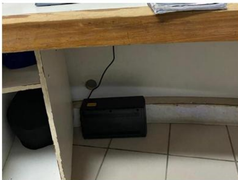
Foto 7 - Instalação de Nobreak para sistema supervisorio
