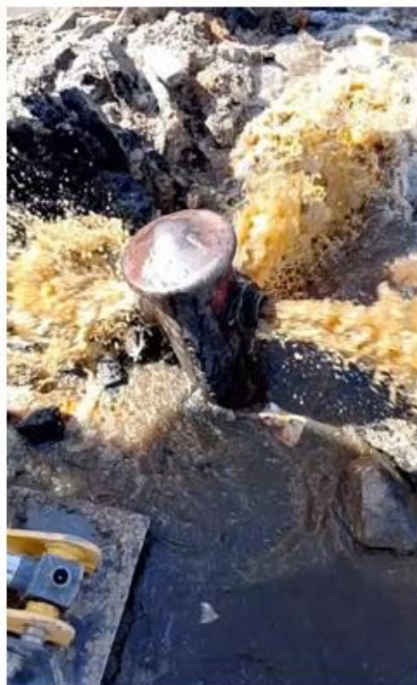
Foto 1 - Descarga de rede realizada em Itabaiana
