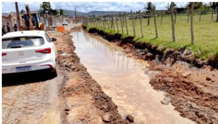
Foto 4 - Reparo de vazamento de rede de distribuição Cajaliba / Mangueiras
