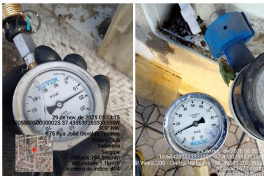
Foto 19 - Medição de pressão no Centro de Itabaiana
