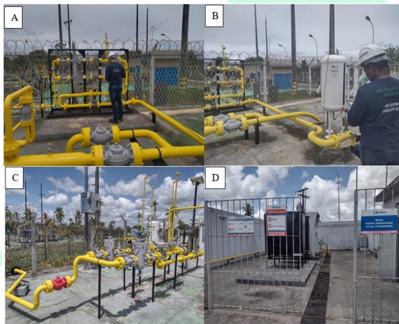
Fotos: Monitoramento do sistema de odoração em: A e B - Estação de Transferência de Custódia (ETC) Águas Claras, C - Estação de Transferência de Custódia (ETC) Estância e D – ERPM Posto Presidente Filial Itaporanga
