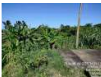
ETE Albano Franco colapsada.
