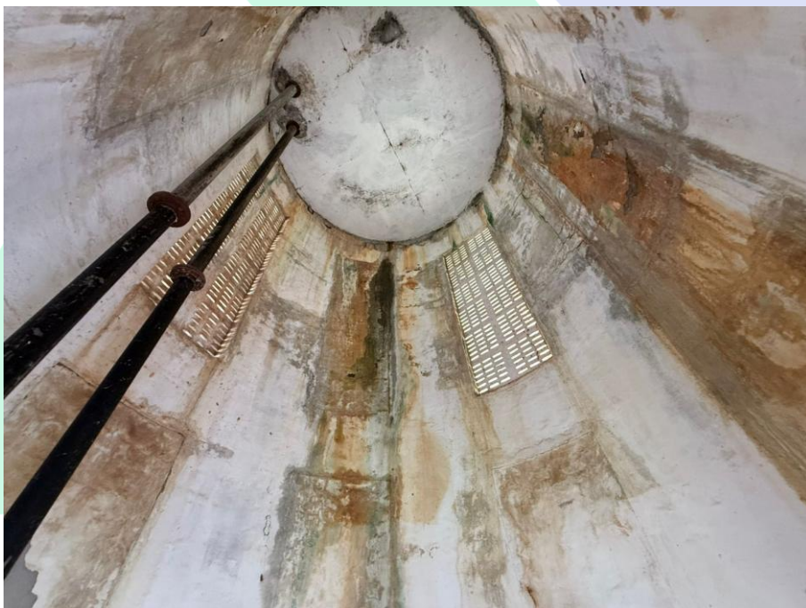
Imagem 2 – Manifestações patológicas existentes no reservatório elevado
