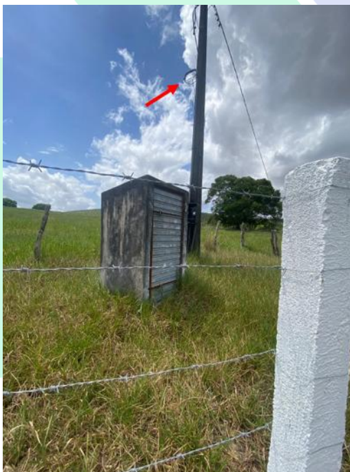
Imagem 6 – Cabeamentos de força do padrão de energia rompidos (área do poço)
