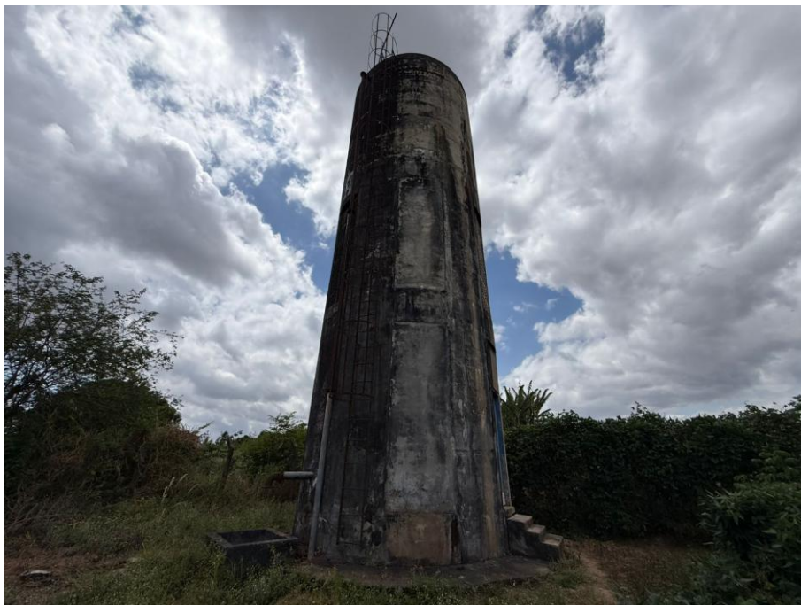
Imagem 2 – Manifestações patológicas existentes no reservatório elevado
