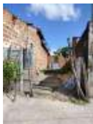
ETE Maria Santana Santos Ocupada e Colapsada
