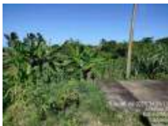
ETE Albano Franco colapsada.
